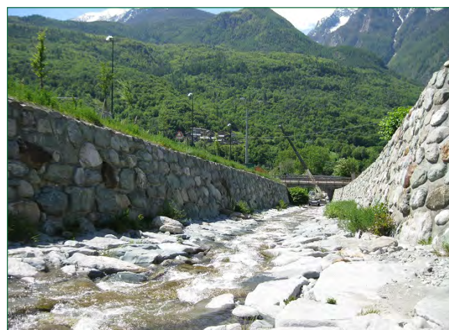
Figura 12 Esempio di alterazione morfologica dell'alveo: T. de Saint-Barthélemy
