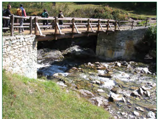
Figura 7 Ponte con spalle in pietre e cemento (T. Ayasse)
