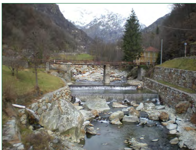
Figura 11 Attraversamento a più luci, difese di sponda e assenza di vegetazione perifluviale (T. Lys - Stato IQM: cattivo)
