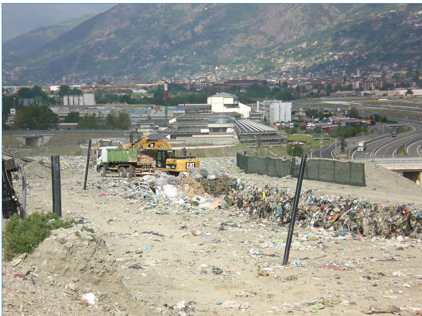
Discarica di Brissogne
