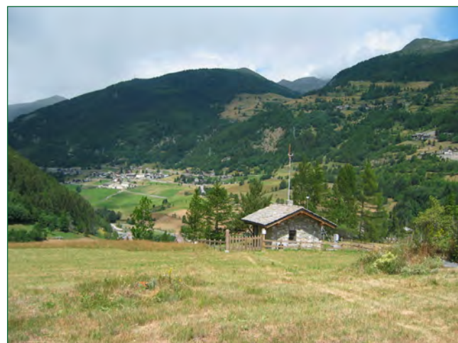
Figura 2 Stazione di Etroubles, località Chevrière (1330 m)
