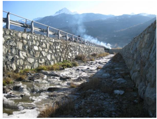
Figura 8 - Torrente Gressan, Gressan
