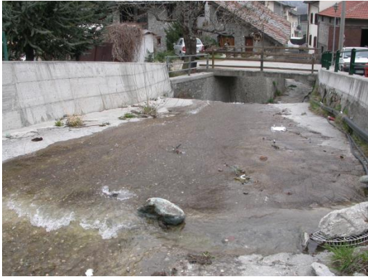
Figura 7 - Torrent Clusellaz, Sarre
