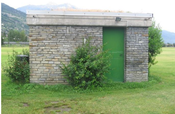
Figura 10 - Pozzo coperto per approvvigionamento idropotabile
