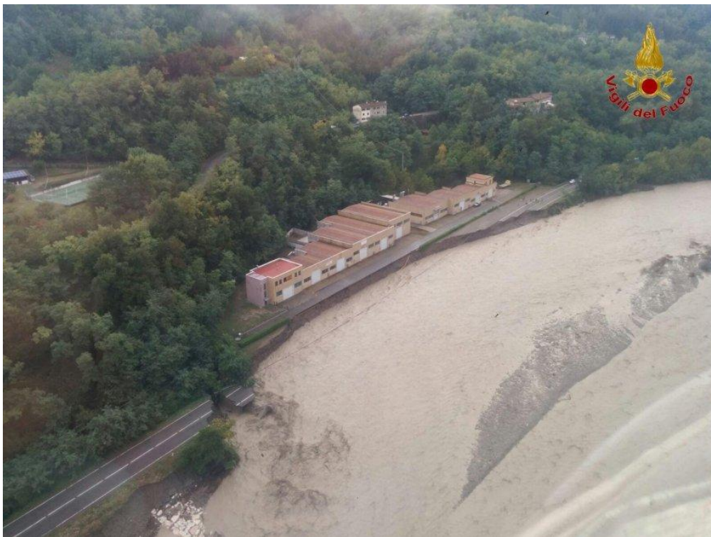
Figura 2.10: Foto aerea della statale che costeggia il fiume Trebbia a Bettola dopo l'alluvione del 14 settembre. Fonte: Corpo Nazionale dei Vigili del Fuoco.
